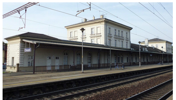
Najdete nás v nádražní budově v Chocni
